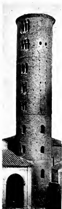
Fig. 77 — Campanile della basilica di Sant'Apollinare Nuovo a Ravenna (a. 850-878)
